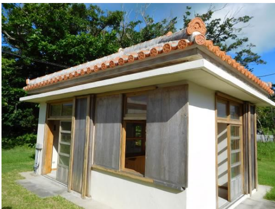
面会室の外観
