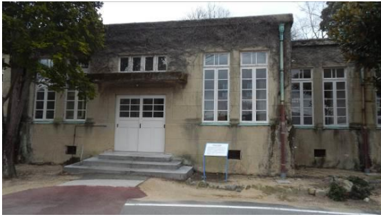
収容所（回春寮）の外観
