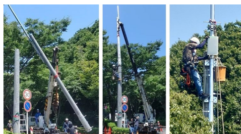
ローカル5G基地局用の建柱作業を行い、頂部にアンテナを設置。
