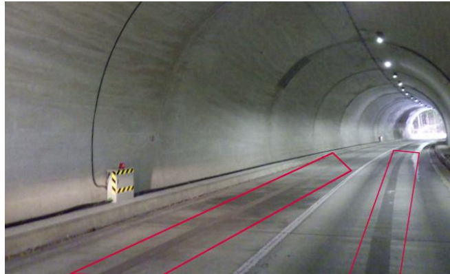
図 6-16 奥四万トンネル内ターゲットライン塗布箇所
