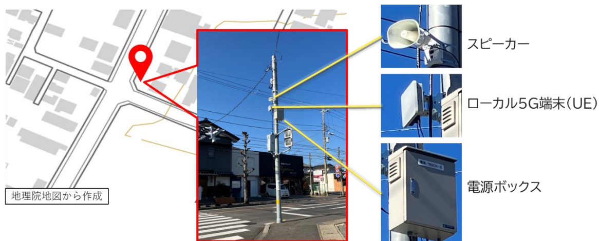
図 5-7 ユースケース2の機器配置(信号柱 I)
