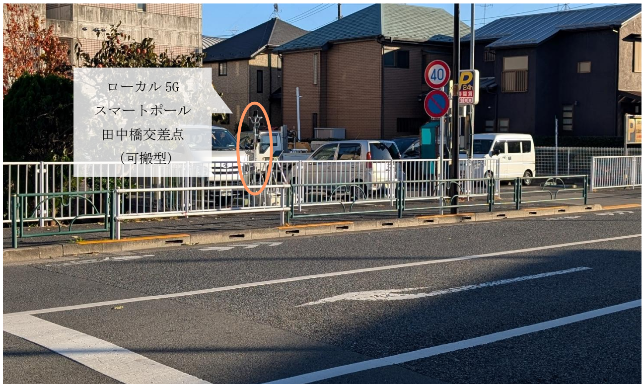
図 4-26 ローカル 5G スマートポール配置写真
