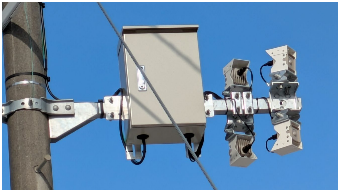
図 15 WiGig 基地局の設置写真
